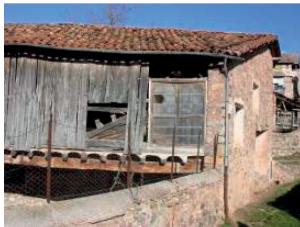
FIGURA 4. Imatge d'un paller amb tancament lleuger de fusta. (Fotografia de l'autor, a la Pobleta de Bellvé, el Pallars Jussà.)
