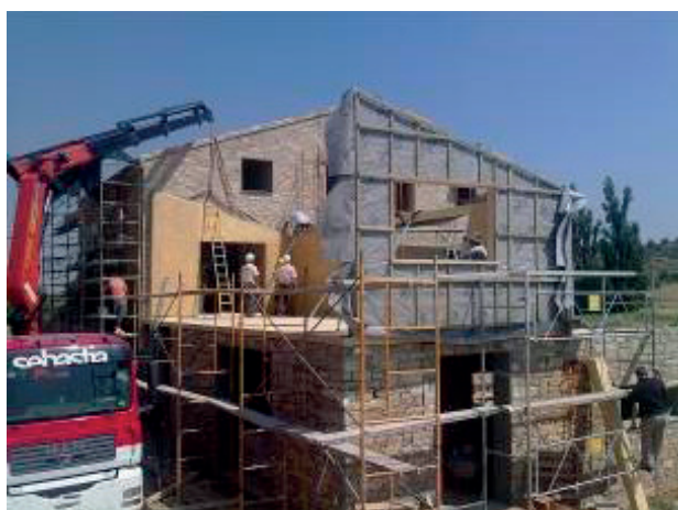
FIGURA 25. Imatge del procés de muntatge dels panells de fusta a l'obra. (Fotografia de l'autor.)
