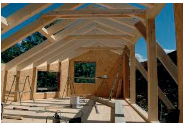
FIGURA 30. Muntatge de l'estructura de fusta de la planta sota coberta i la coberta amb estructura de murs prefabricats de fusta i coberta muntada in situ , amb elements mecanitzats sense carener i tirants que absorbeixen les empenes horitzontals de les bigues. (Fotografia de l'autor.)
