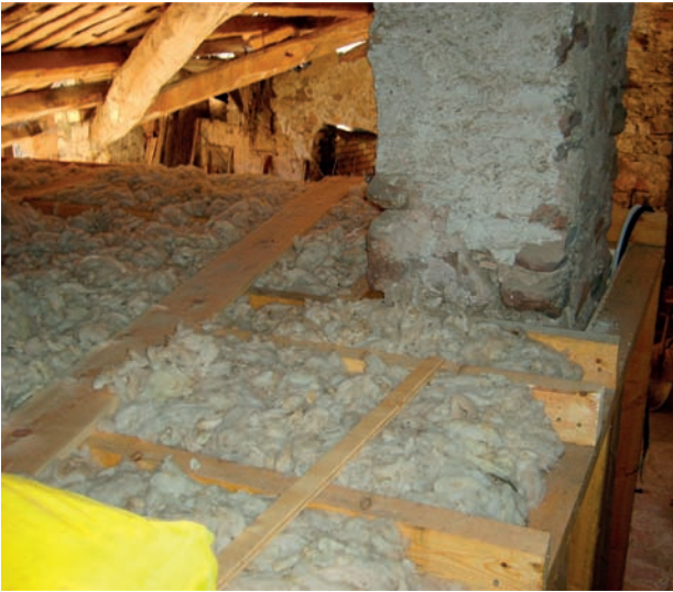
FIGURA 14. Imatge de la col·locació d'aïllament de llana d'ovella a la coberta de la caixa de fusta. (Fotografia de l'autor.)
