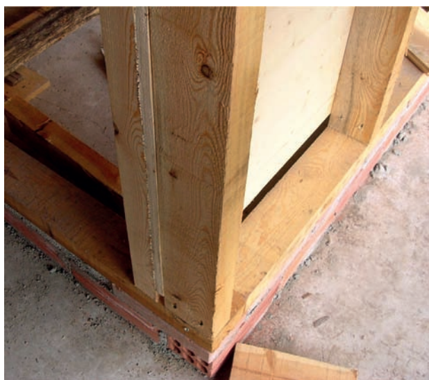
FIGURA 10. Imatge de la construcció de l'esquelet de fusta i el seu enriostament. (Fotografia de l'autor.)
