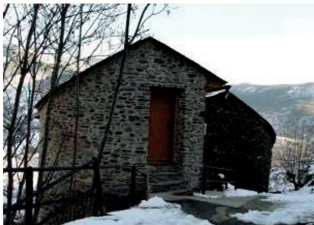
FIGURA 36. Imatge de l'exterior de la façana est, la part de pedra que s'ha remuntat seguint la geometria del mur inferior i amb una textura similar, utilitzant morter de calç com a conglomerant per tal de garantir la transpirabilitat de la pedra enfront del mur de fusta aïllat al seu interior. (Fotografia de l'autor.)
