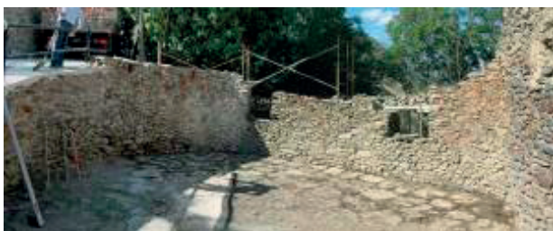
FIGURA 33. Imatge de l'estat de les obres un cop anivellat el mur de pedra existent, per tal de fer un cercle de repartició de càrregues i unió de la part superior del mur de pedra amb l'arribada del forjat de fusta. (Fotografia de l'autor.)
