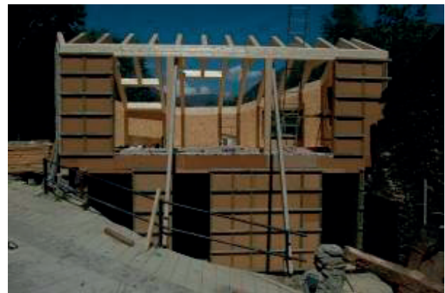
FIGURA 34. Imatge del muntatge de l'estructura de fusta vist des de la façana sud. El volum i les obertures ja estan formats i els rastells de ventilació de la façana de fusta han estat col·locats a fàbrica. In situ només caldrà segellar els panells i col·locar-hi els vidres i la fusta de larix com a acabat exterior. (Fotografia de l'autor.)
