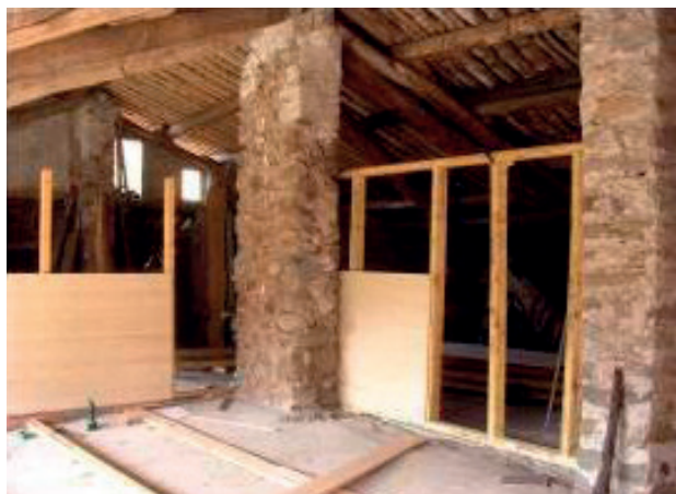
FIGURA 9. Imatge de l'inici del muntatge autoconstruït de la caixa de fusta dins el paller. (Fotografia de l'autor.)
