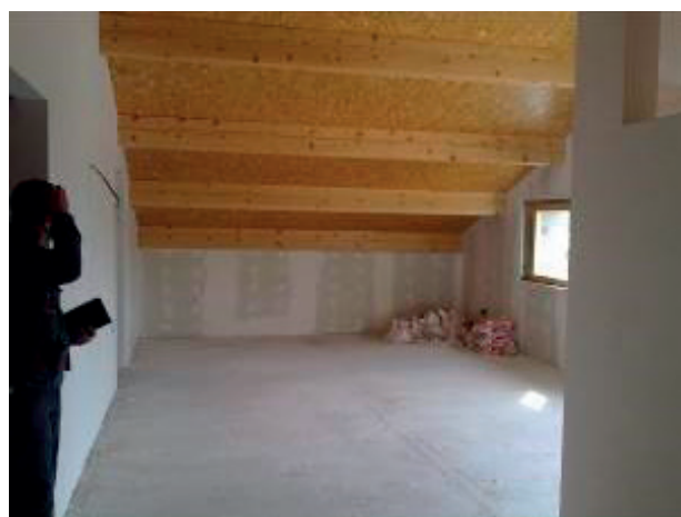
FIGURA 27. Imatge interior de l'espai sota coberta de l'edifici rehabilitat amb la coberta prefabricada de fusta. (Fotografia de l'autor.)
