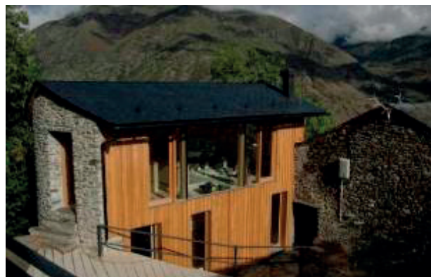
FIGURA 38. Imatge exterior de la façana lleugera de fusta i vidre, completament acabada a principis d'octubre del 2012. A les 16 h, el sol entra de manera abundant cap a l'interior sense que el ràfec de la coberta n'obstrueixi el pas. El mur de pedra present als laterals indica la closca pesant que protegeix l'edifici del vent del nord i li dona solidesa visual i arrelament amb el passat històric. (Fotografia de l'autor.)
