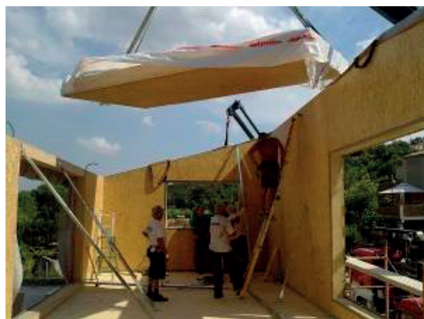
FIGURA 26. Imatge del muntatge dels panells de l'edifici annex a l'obra. (Fotografia de l'autor.)
